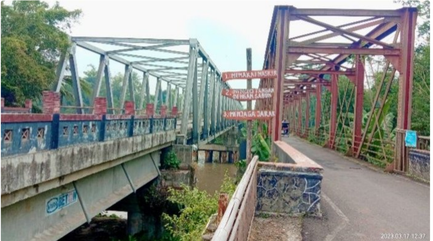
Dua Jembatan di Patikraja, Jembatan Merah Patikraja Dan Jembatan Baru
